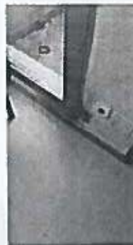
Imagen 6: Humedad en la zona baja de la puerta de acceso al balcón
