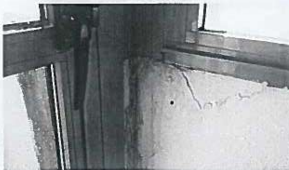
Imagen 23: Humedad en la zona de la puerta de acceso al balcón
