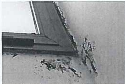
Imagen 39: Detalles de filtraciones provocadas
