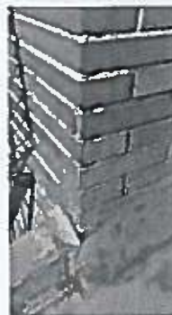
Imagen 13: Impermeabilización punto singular y deterioro de ladrillo caravista
