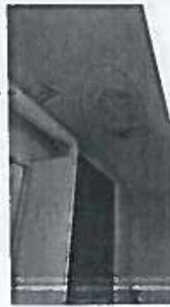
Imagen 8: Humedad en la cocina, probablemente procedente del deficiente sellado de los pasos de cubierta
