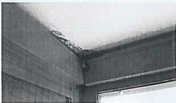
Imagen 22: Humedades en el encuentro de techo, fachada y carpintería
