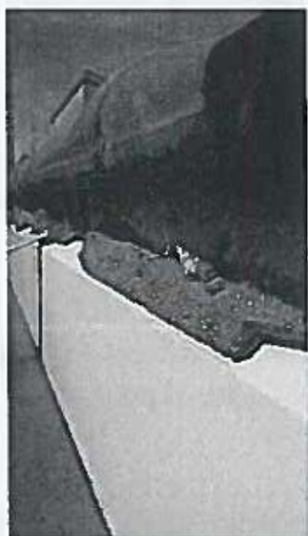
Imagen 31: Recibido del canalón. Presencia de mortero conectando entre canalón y cubierta
