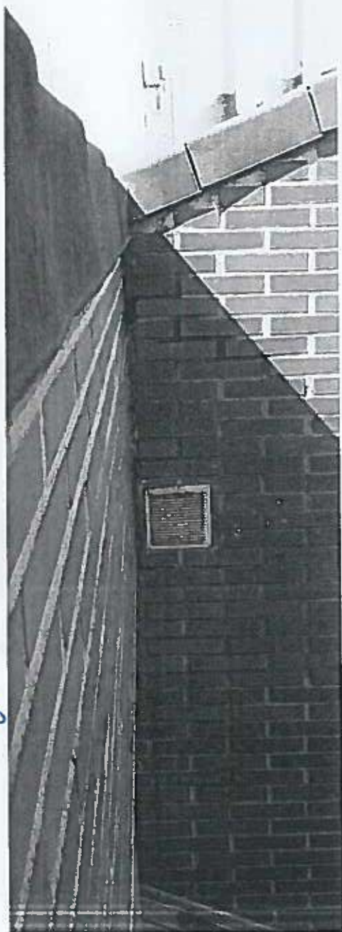
Imagen 34: Humedad en fachada junto a chimenea
