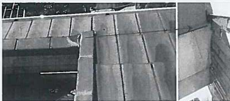
Imagen 32: Se detecta acumulación de agua humedad bajo puntos singulares que protegen el límite de la cubierta.
