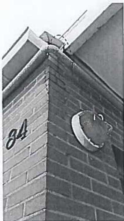
Imagen 17: Aparición de filtración junto a la puerta de acceso a la vivienda
