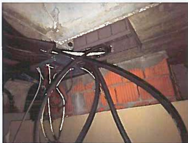
Fig. 16 Entrada de cables a VIVA
