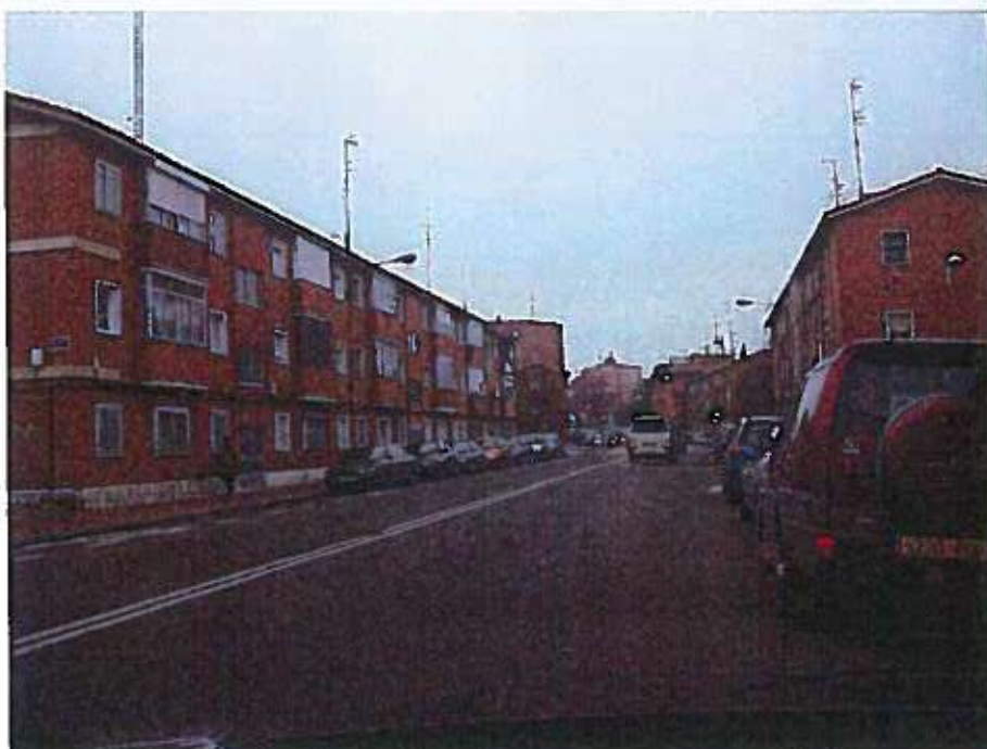
Carretera de Villabañez. Calzada en relativo buen estado, bandas de aparcamiento incorporadas en calzada.
